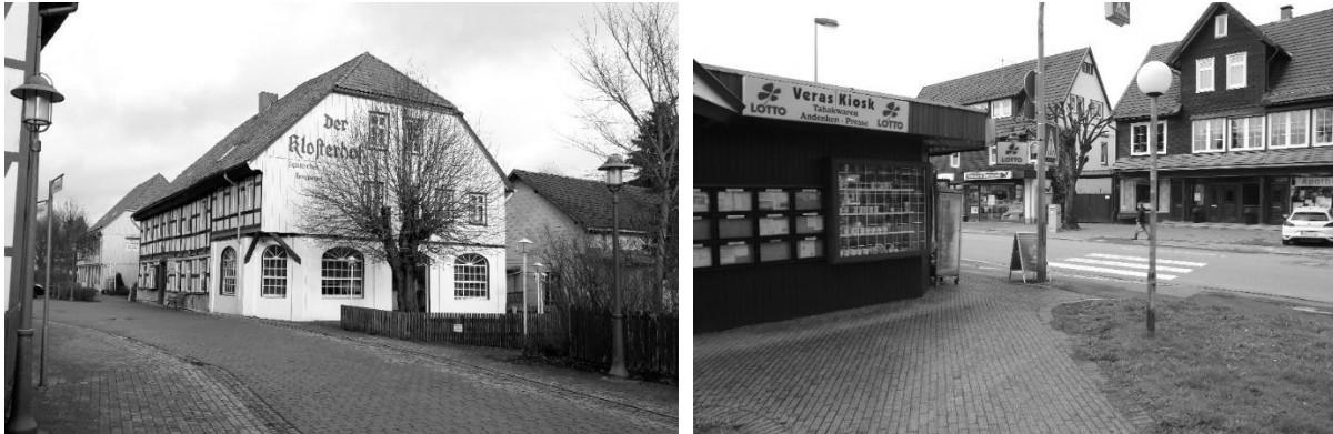
Abb. 14 Beispiel Gaststätte in Betrieb und Versorgungsinfrastruktur
